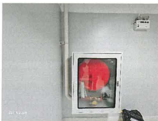
รูปที่ 55 เก็บสายฉีดน้ำดับเพลิงพร้อมอุปกรณ์ (Fire Hose Cabinet : FHC) ไว้ภายในอาคาร
