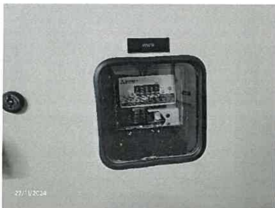
รูปที่ 14 ระบบมิเตอร์ไฟฟ้าสำหรับระบบบำบัดน้ำเสีย
