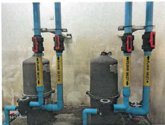
รูปที่ 84 ระบบกรองน้ำสระว่ายน้ำ
