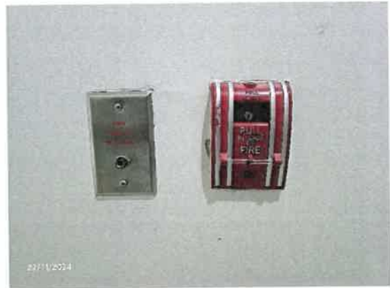
รูปที่ 60 เครื่องแจ้งเหตุโดยใช่มือดึง (Manual Station)
