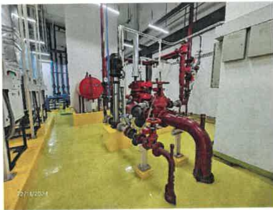
รูปที่ 50 เครื่องสูบน้ำดับเพลิงอยู่ในห้อง เครื่องสูบน้ำดับเพลิงภายในอาคารบริเวณชั้นที่ 1
