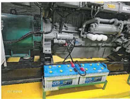
รูปที่ 90 แบตเตอรี่สำรอง
