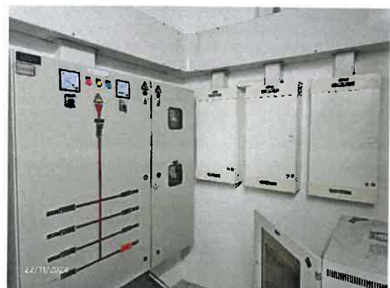
รูปที่ 14 ระบบมิเตอร์ไฟฟ้าสำหรับระบบบำบัดน้ำเสีย
