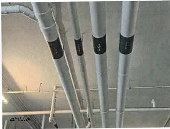
รูปที่ 36 ท่อรวบรวมน้ำเสียจากห้องพักมูลฝอย
