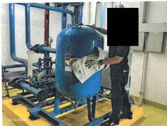
รูปที่ 20 ช่างซ่อมบำรุงตรวจสอบรอยรั่ว
