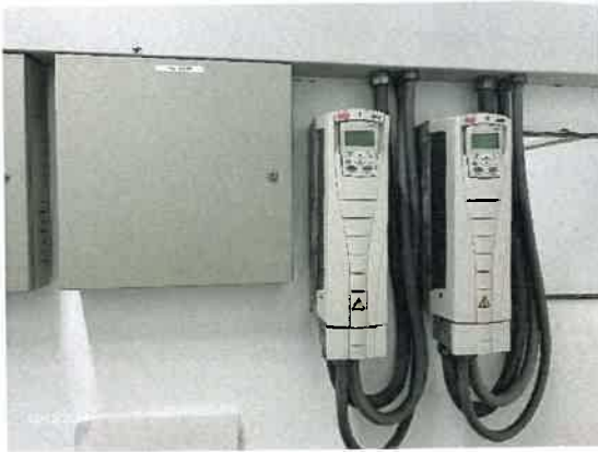
รูปที่ 48 อุปกรณ์ปรับความเร็วรอบมอเตอร์ VSD
