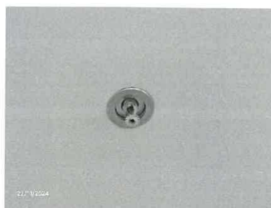
รูปที่ 56 ระบบหัวกระจายน้ำ ดับเพลิงอัตโนมัติ (Sprinkler System)
