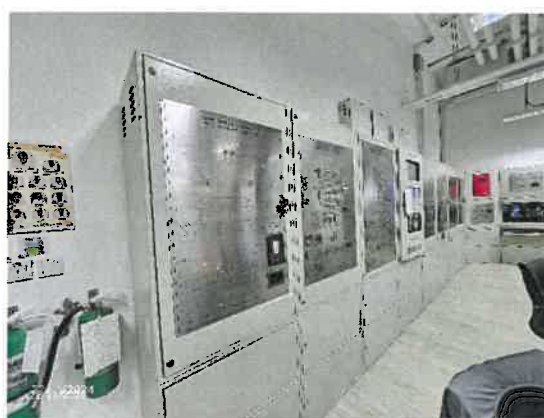
รูปที่ 57 แผงควบคุม เพื่อทำหน้าที่เป็นจุดศูนย์รวม การรับ-ส่งสัญญาณตรวจรับ
