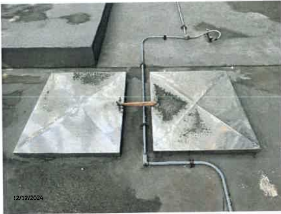
รูปที่ 17 ฝาดังเก็บน้ำสำรอง บริเวณฝาดังเก็บน้ำชั้นหลังคา
