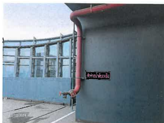
รูปที่ 54 หักรับน้ำดับเพลิงภายนอกอาคาร (FDC)
