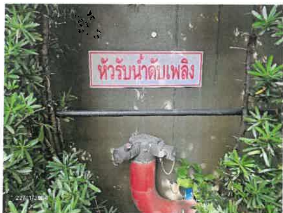
รูปที่ 54 หักรับน้ำดับเพลิงภายนอกอาคาร (FDC)
